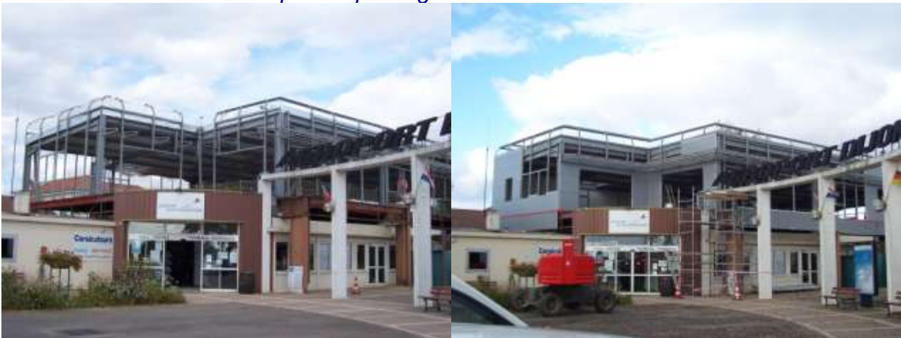
Quelques images de l'avancée des travaux...
